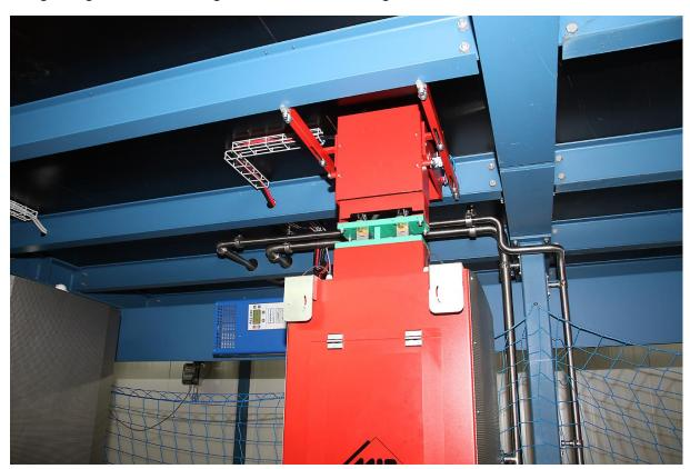
Die Retrofit-Fahrzeuge haben eine Lithium-Ionen-Batterie an Bord. Diese sind schnellladefähig, verbleiben im Fahrzeug und werden über Deckenkontakte von sechs Ladegeräten automatisch geladen (Foto: MLR)
