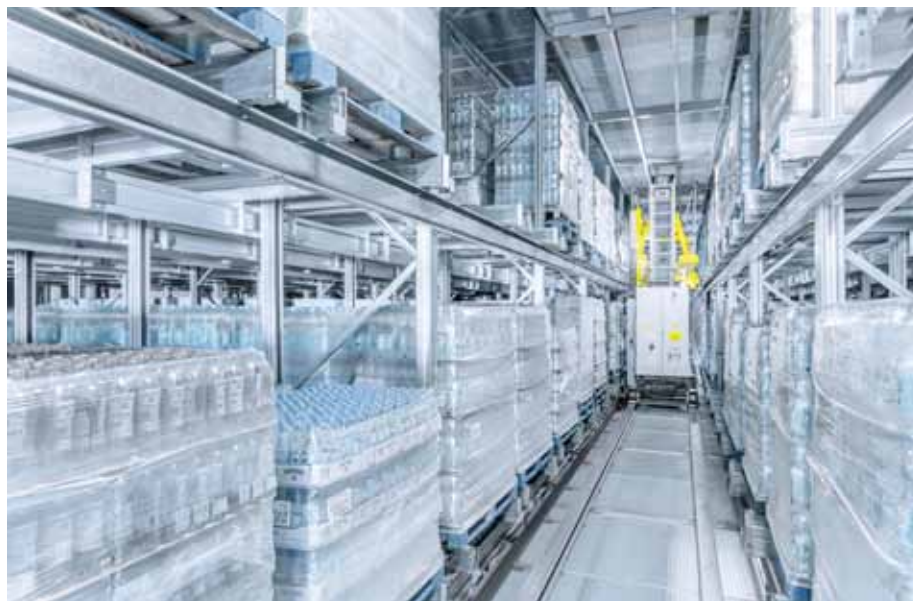
Schlanke und nachhaltige Prozesse, optimale Flächennutzung, Steigerung der Produktivität und Servicequalität, höherer Durchsatz und intelligentere Arbeitsplätze – die Konzeption und Technik des neuen Kompaktlagers von SSI Schäfer hat die Logistik von Gerolsteiner deutlich verbessert (Foto: SSI Schäfer)
